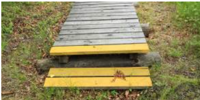
Рис. 61. Все стыки настила помечены яркой краской для повышения безопасности передвижения
