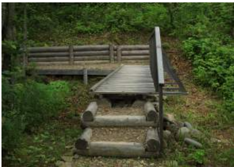
Рис. 54. К мосту ведут насыпные ступени с каркасом из специально обтесанных бревен – технология, описанная в книге Боба Биркби «Тропа, парящая над землей» [16]
