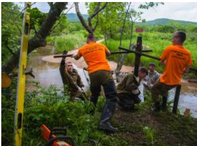
Рис. 51. Установка опор будущего моста
