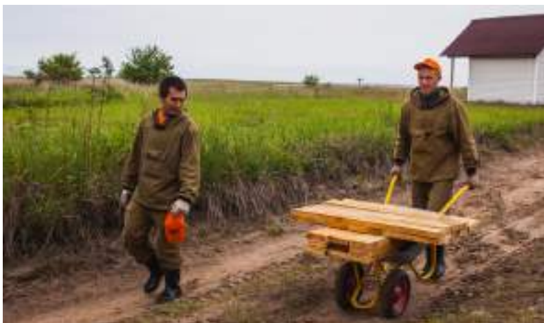
Рис. 73. Строительные работы на кордоне повысили его привлекательность для туристов
