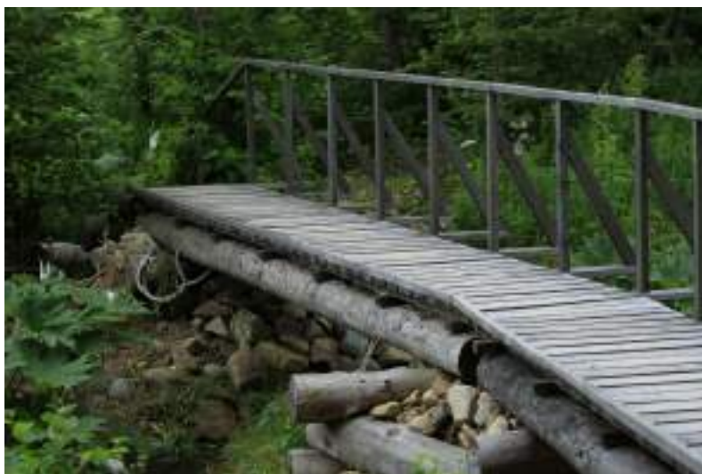
Рис.55. Мост на тропе «Мыс Северный» сделан из лиственницы, древесина которой не требует дополнительной обработки, оборудован укрепленными перилами
